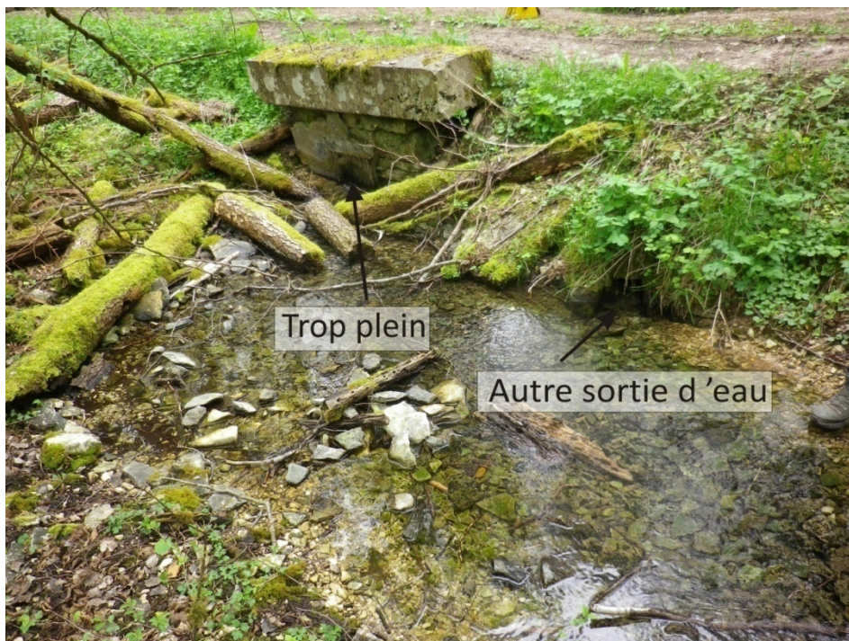
Figure 8 : Vue sur le trop plein situé de l'autre côté du chemin.
