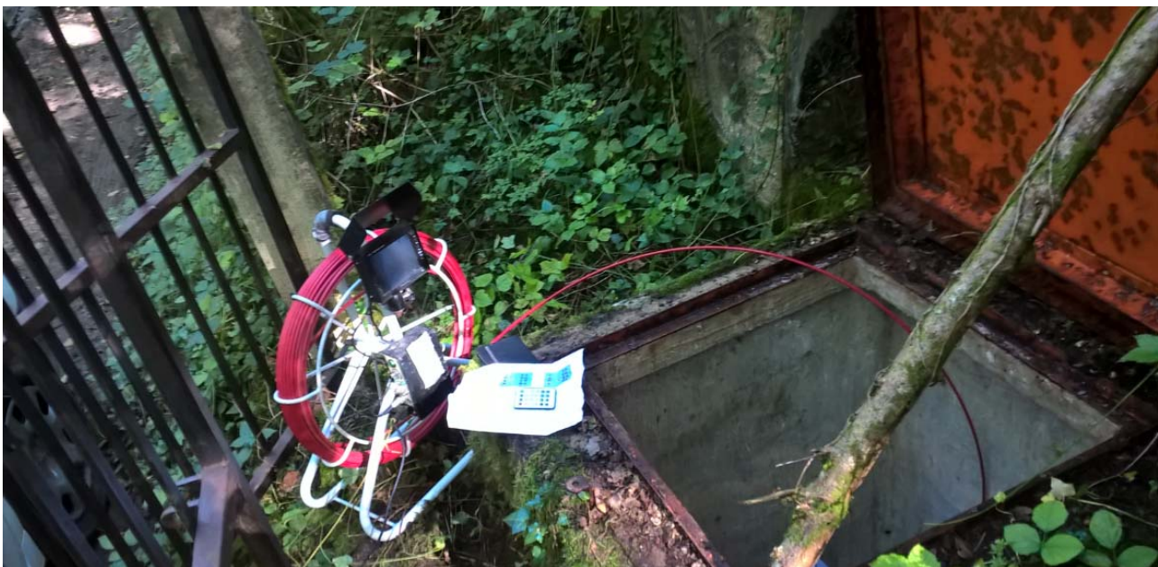
Figure 3 : Inspection en cours.
