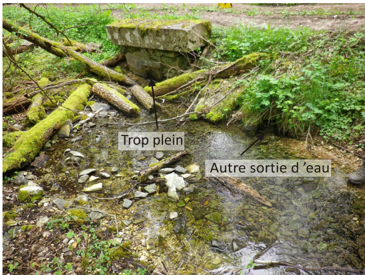
Figure 9 : vue sur le trop-plein situé de l'autre côté du chemin.
