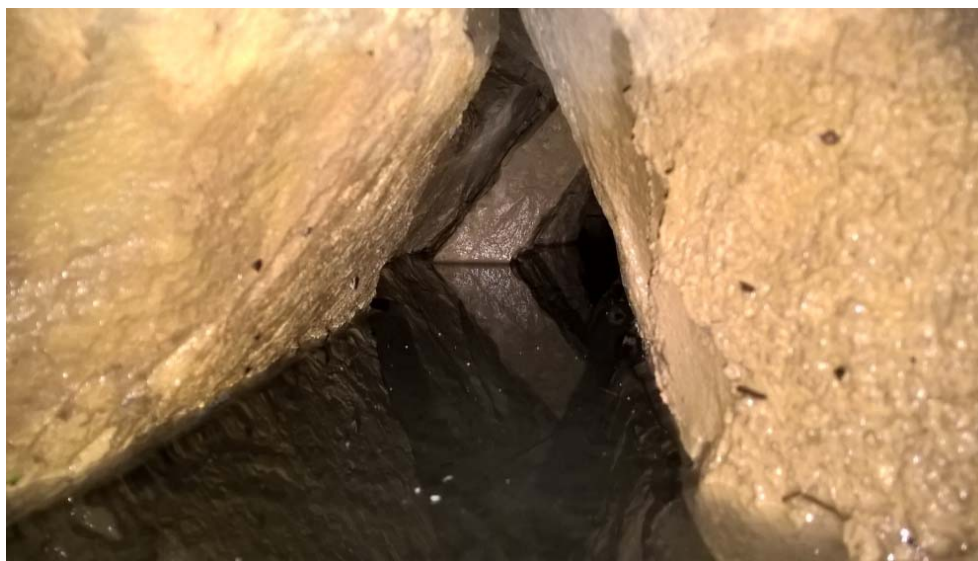
Figure 6 : Vue sur le drain n°2 depuis le captage.
