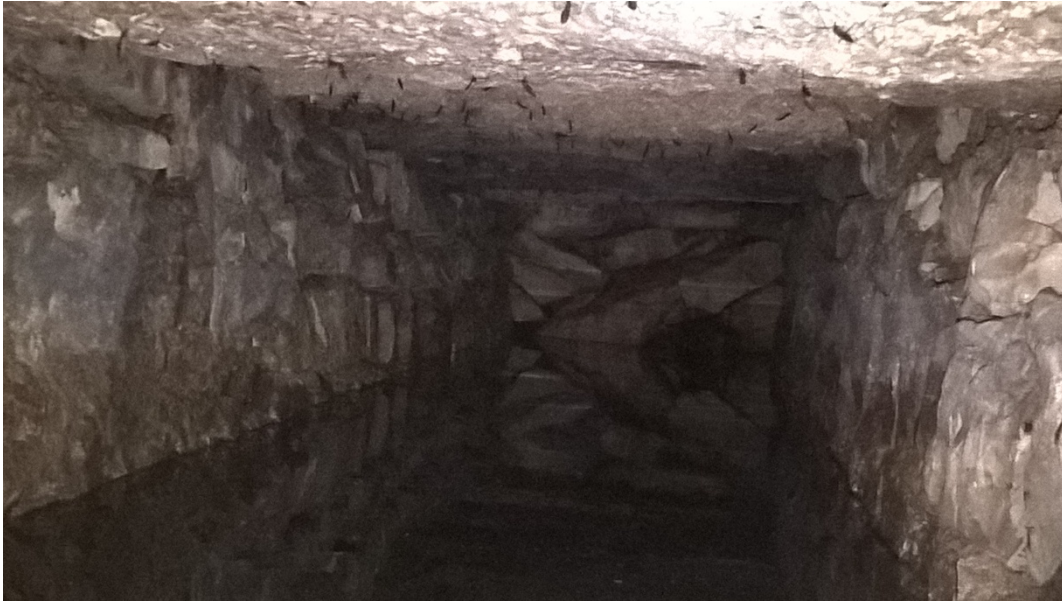
Figure 7 : vue sur le drain n°3 depuis le captage.
