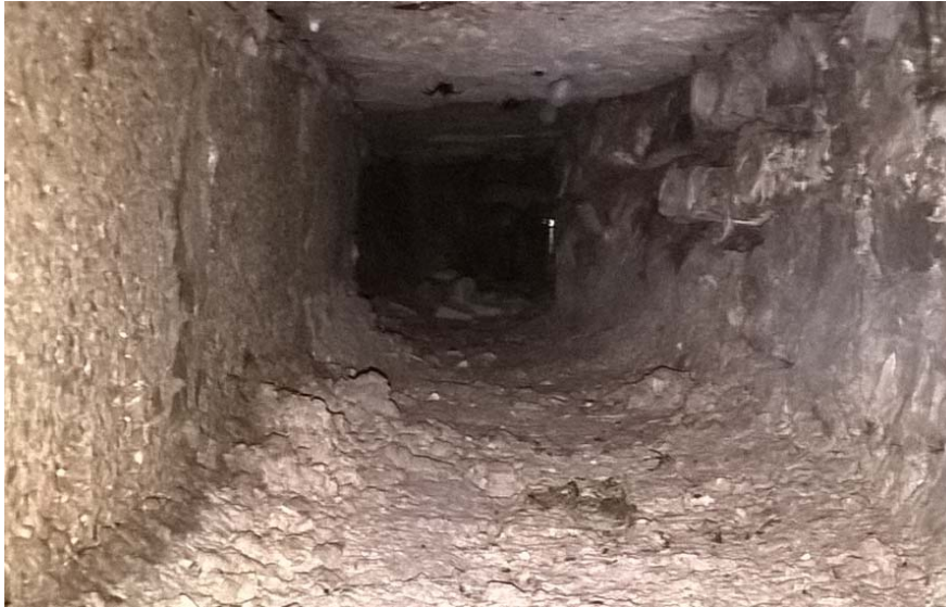
Figure 4 : Vue sur la canalisation de trop plein depuis le captage.
