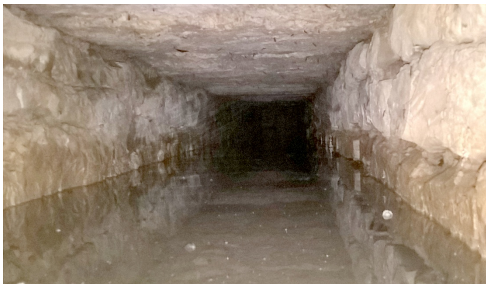
Figure 5 : Vue sur le drain n°1 depuis le captage.
